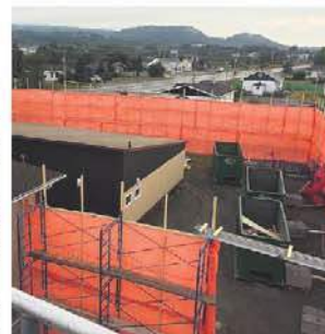
La démolition de l'annexe contaminée repousse la rentrée des classes d'une semaine à l'école de l'Anse. (Photo GracienLenté)
