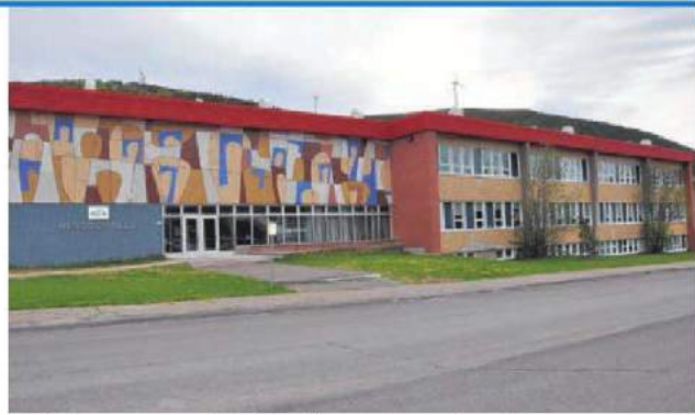
L'école des Prospecteurs de Murdochville recevra 400 000 $ pour les murs extérieurs, des projets de rénovation des salles de bain et la réfection d'un mur de bloc de verre au gymnase. (Photo TC Media – Jean-Philippe Thibault)
