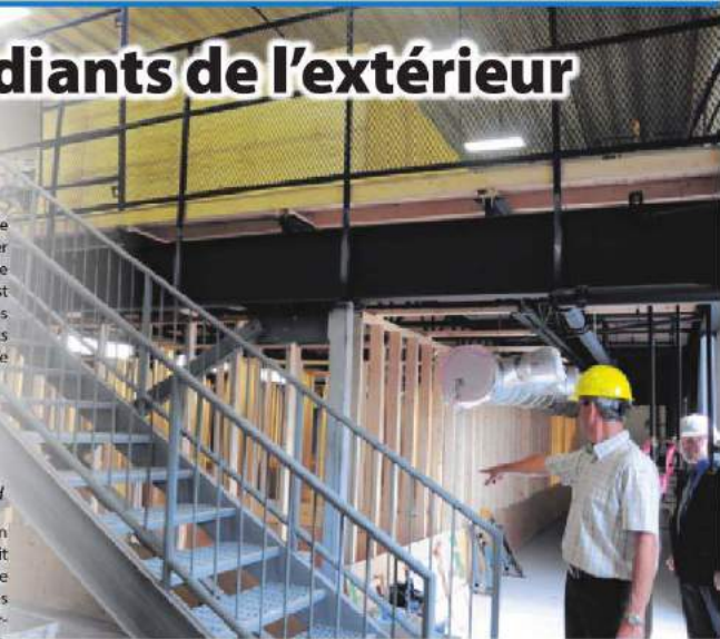
Plomberie et chauffage est l'un des programmes ciblés par le projet d'accès au logement de la Commission scolaire des Chic-Chocs. (Photo TC Media - Dominique Fortier)
