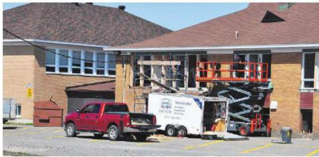
L'école de l'Anse a vu toutes ses fenêtres être remplacées au cours de l'été. (Photo TC Media - Dominique Fortier)
