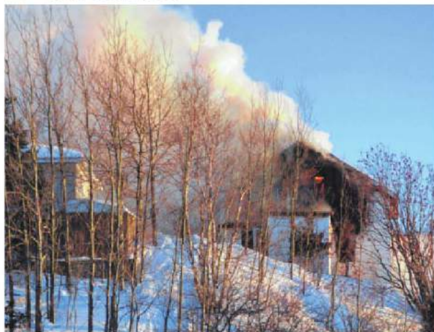
Le feu s'échappait des fenêtres de deux étages de l'immeuble à l'arrivée des pompiers. (Photo TC Media)
