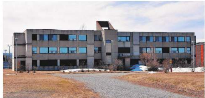
Les résidences sont inoccupées depuis bientôt 12 ans. (Photo TC Media - Dominique Fortier)
