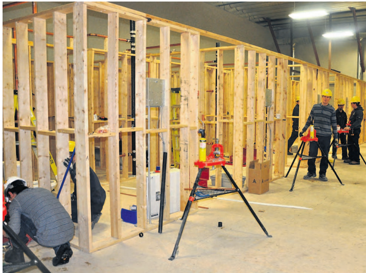
Les installations pour le programme en plomberie et chauffage reproduisent l'intérieur d'une maison où tout est à faire. (Photo L'Avantage gaspésien - Dominique Fortier)
